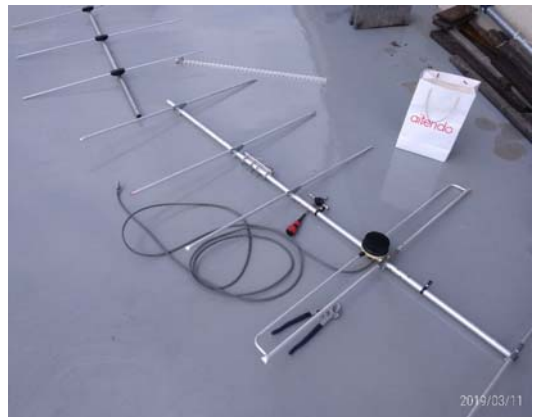
屋上で組み立て中↑
